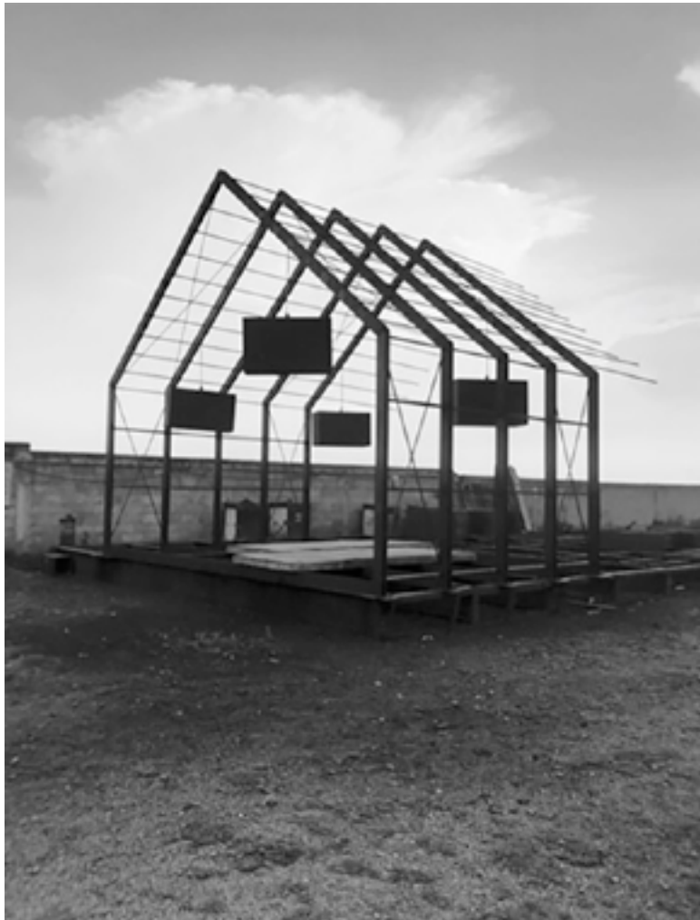
R. Rosetta, premontaje de estructura prefabricada, TALLERochaCarrillo. Fotografía: ©Mauricio Rocha.
