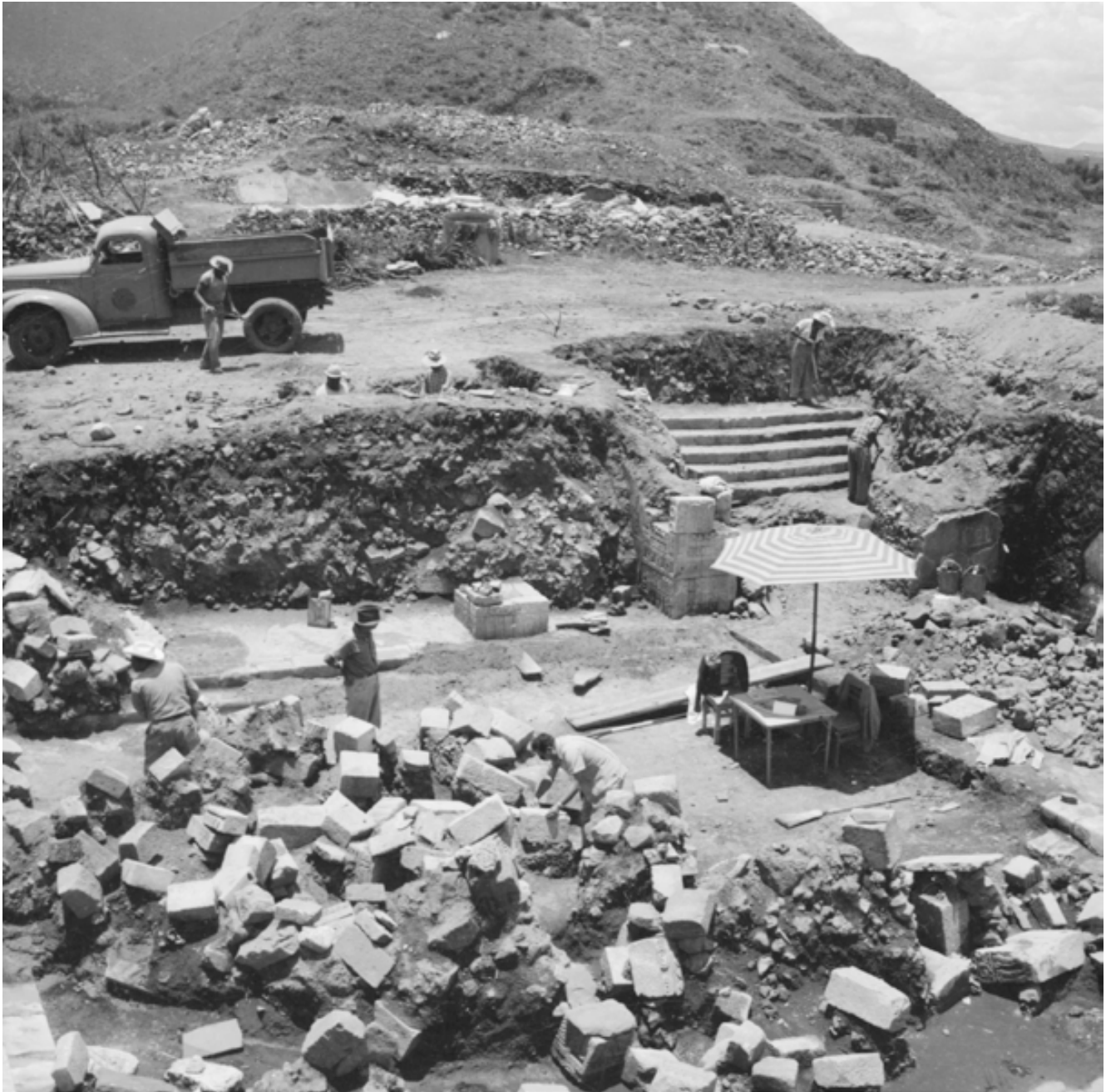
Lámina 10. Ponciano Salazar Ortegón revisando los restos de los pilares colapsados sobre el piso del Patio de los Pilares en el Palacio de Quetzalpapálotl, temporada III, foto 1962 (INAH-SINAFO, no. 370564).
