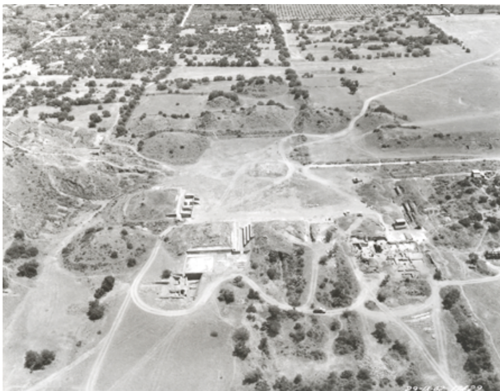
Lámina 7. Foto aérea (oeste-este) de los trabajos de liberación y reconstrucción ejecutados en las fachadas Edificios 1, 3, 4, 5 y espacios interiores del Palacio de Quetzalpapálotl, Plaza de la Luna, Compañía Mexicana Aerofoto, 22/IX/1962 (INAH-ATCNA, Fototeca, Estado de México, caja 14).
