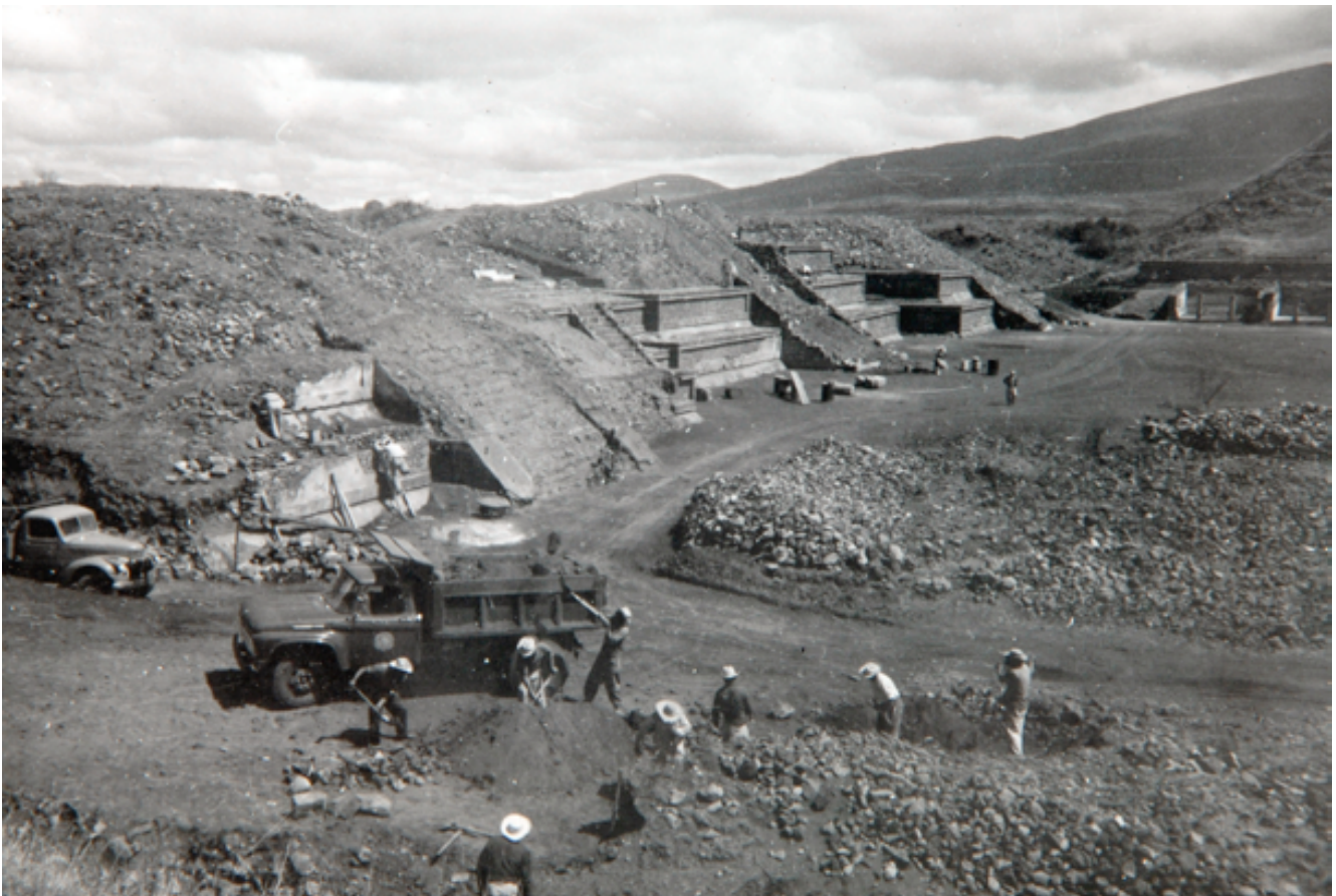
Lámina 8. Trabajos de reconstrucción de cuerpos inferiores, escaleras de los Edificios 1, 3, 4, 5 en el lado oeste Plaza de la Luna (INAH, SINAFO, no. 371965).
