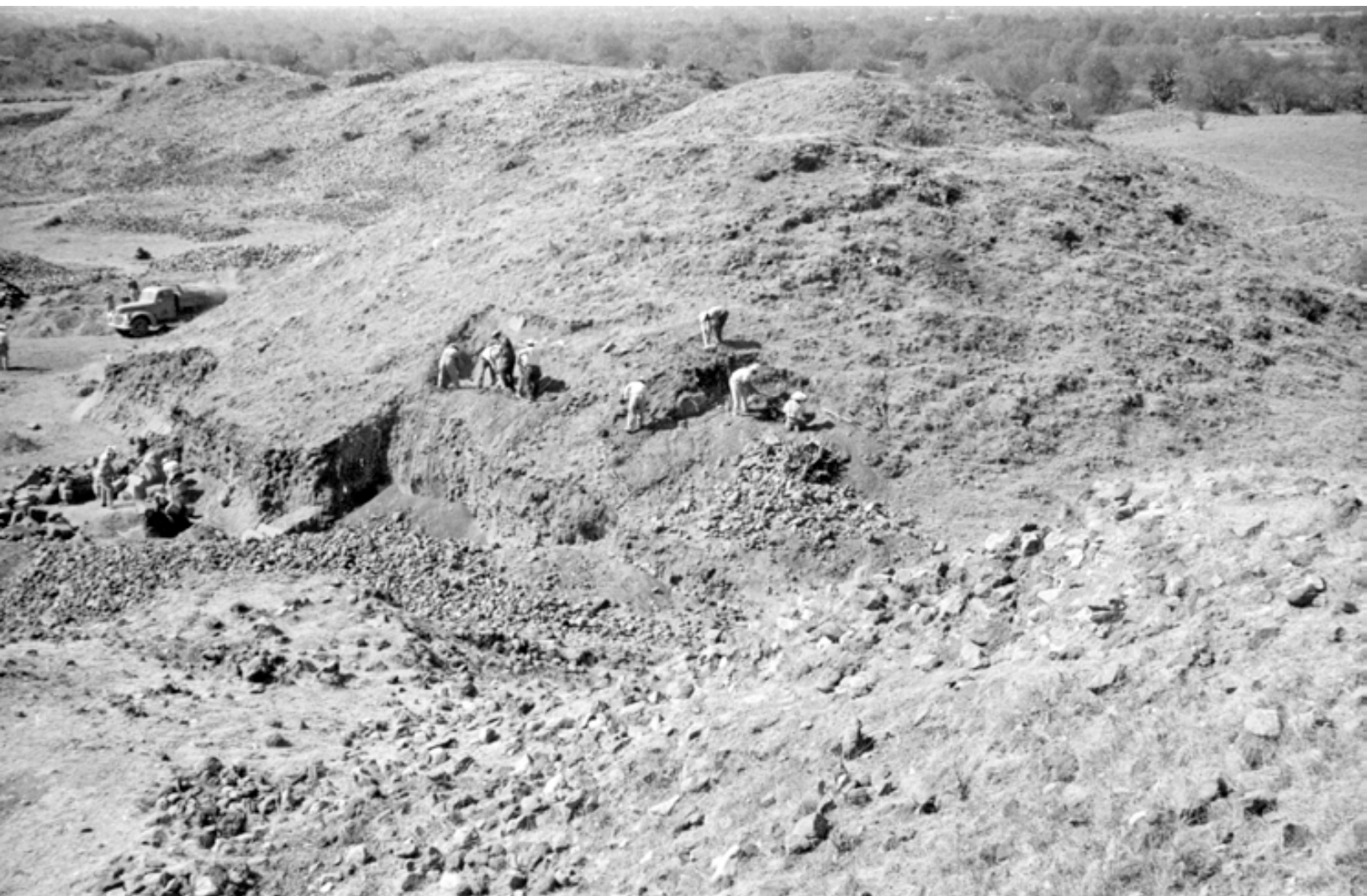
Lámina 5. Inicio de retiro de escombros en la fachada del Edificio 1; atrás, montículos del lado oeste de la Plaza de la Luna, comienzo de la temporada I, foto 1960 (INAH-SINAFO, no. 370456).
